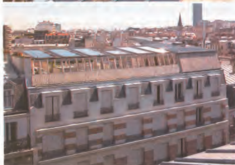
Pose de capteurs thermiques et photovoltaïques sur la surélévation d'une résidence sociale et universitaire, Paris XV e . (Docs. R.Delaclotche/Observ'et Agence Équateur)
