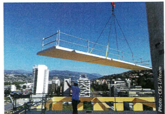
↑ Pose d'un plancher CLT.
