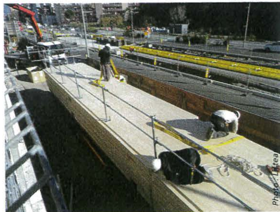
↑ Arrivée des panneaux par semi-remorque.
