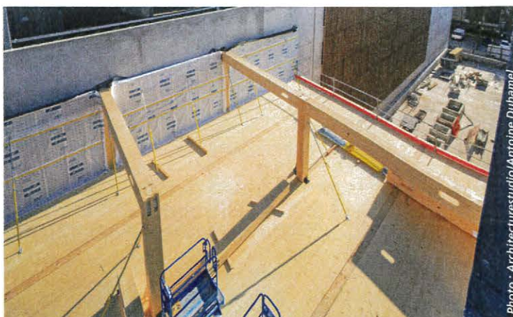
↑ Pose des poutres BL-C.
