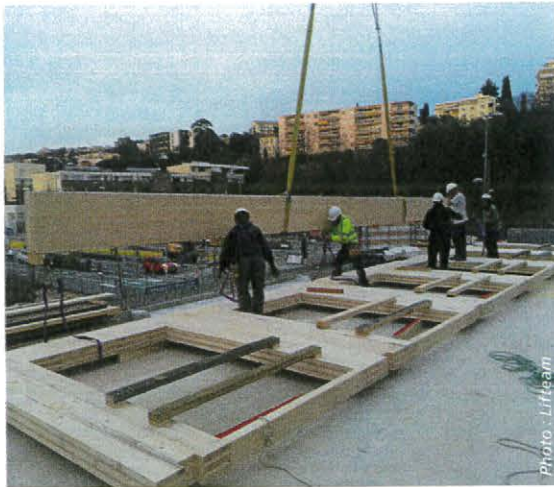
↑ Assemblage au sol des façades CLT.
