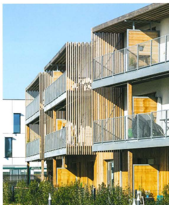
▲ Côté jardin, les logements bénéficient de larges balcons en bois et structure métallique.
