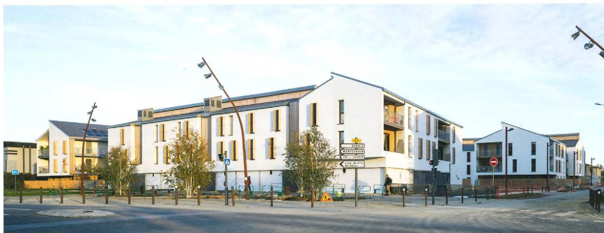
▲ Le bois se fait discret sur la façade nord rythmée par les étroites fenêtres verticales.
