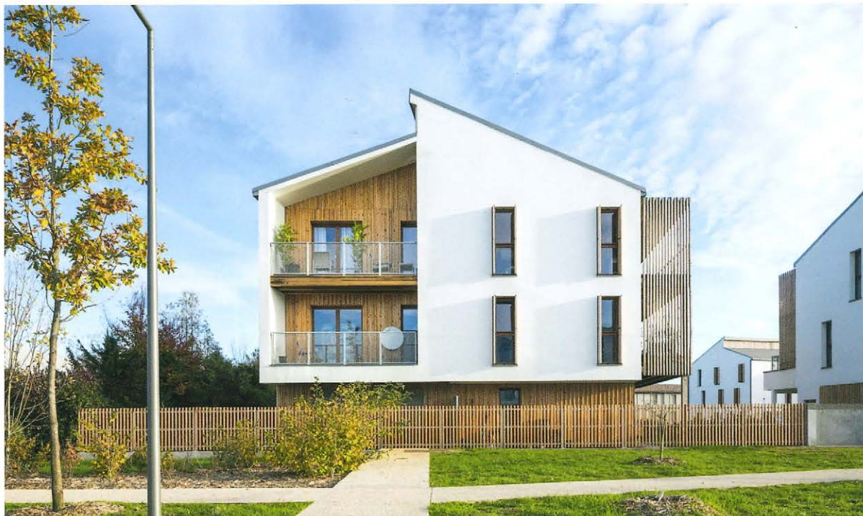
▲ La façade-pignon se caractérise par l'alternance d'un bardage filigrane en mélèze et d'ouvertures verticales.
