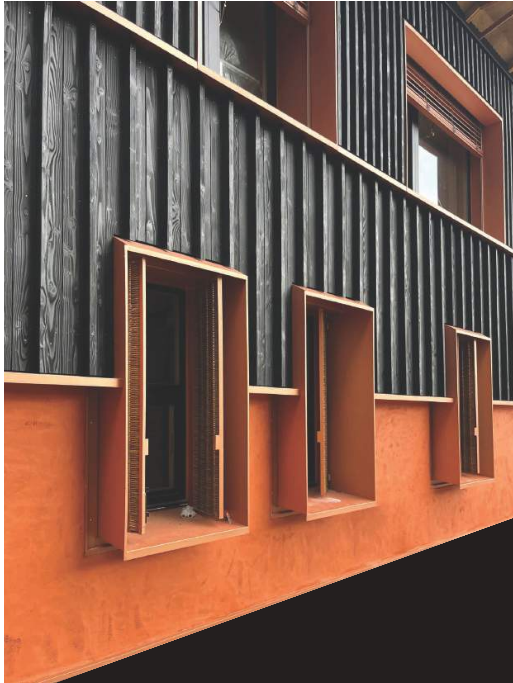
Façade extérieure, bardage de bois brûlé + enduit chaux
