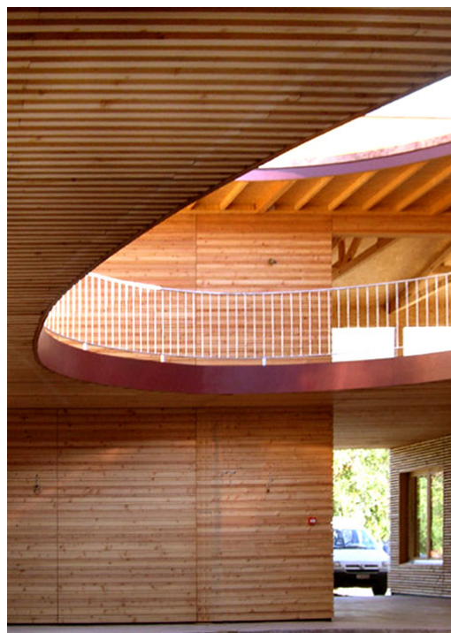
Figure 7 : Exemple type du plafond obtenu avec une dalle O'portune® en planches décalées
