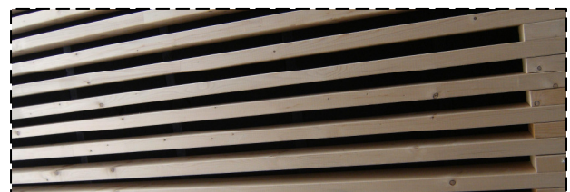
Figure 16 : Correcteur acoustique en fond d'onde avec feutrine de couleur visible au choix de l'architecte
