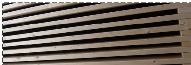
Figure 16 : Correcteur acoustique en fond d'onde avec feutrine de couleur visible au choix de l'architecte
