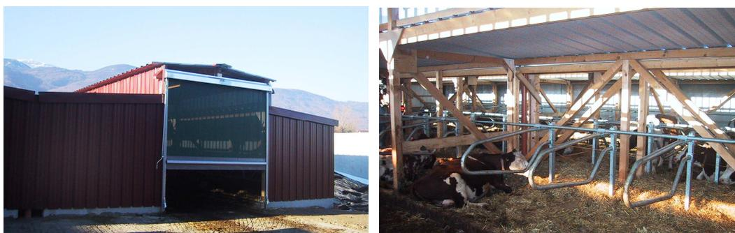
Fig. 1 : Extérieur du bâtiment en bardage métallique et intérieur avec les séparations
