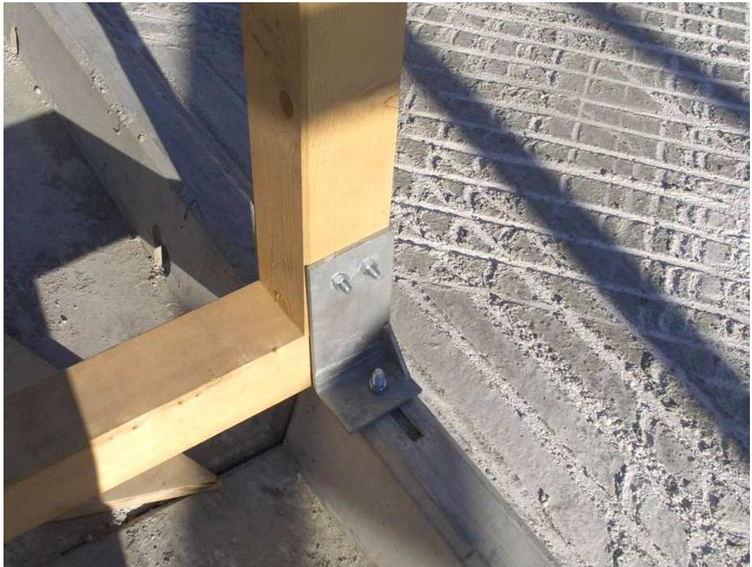
Fig. 4 : Ferrure reliant le bois et la fondation bétonnée
