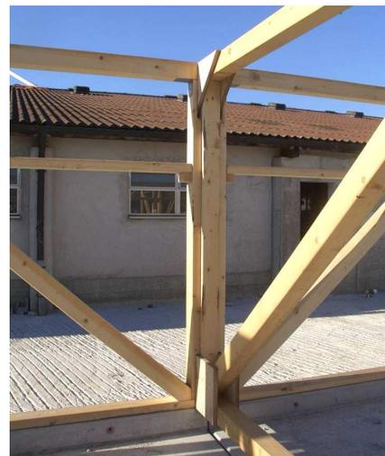
Fig. 6 : Assemblages des portiques par inserts en contreplaqué, cloués ou vissés
