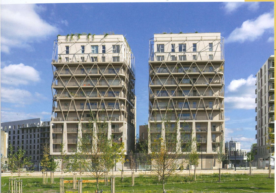
Livrée à l'été 2025 à Bordeaux, la résidence Iksoo, conçue avec l'agence CoBe Architecture et Paysage, combine densité jusqu'à R+10 et usage majoritaire de matériaux biosourcés, notamment le bois.
