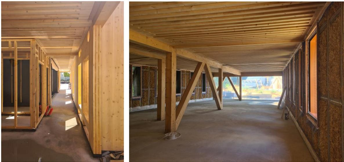
Image 6 : Porteurs CLT + Planchers Solives bois massif (O'portune®) / Porteurs MOB et poteaux-poutres bois + plancher solives bois massif (O'portune®).
