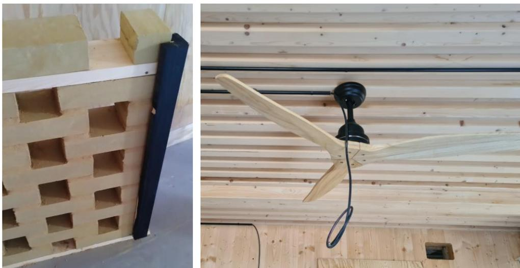
Image 5 : Montage des moucharabiehs microclimatiques – « radiateur froid » et des brasseurs d'air.
