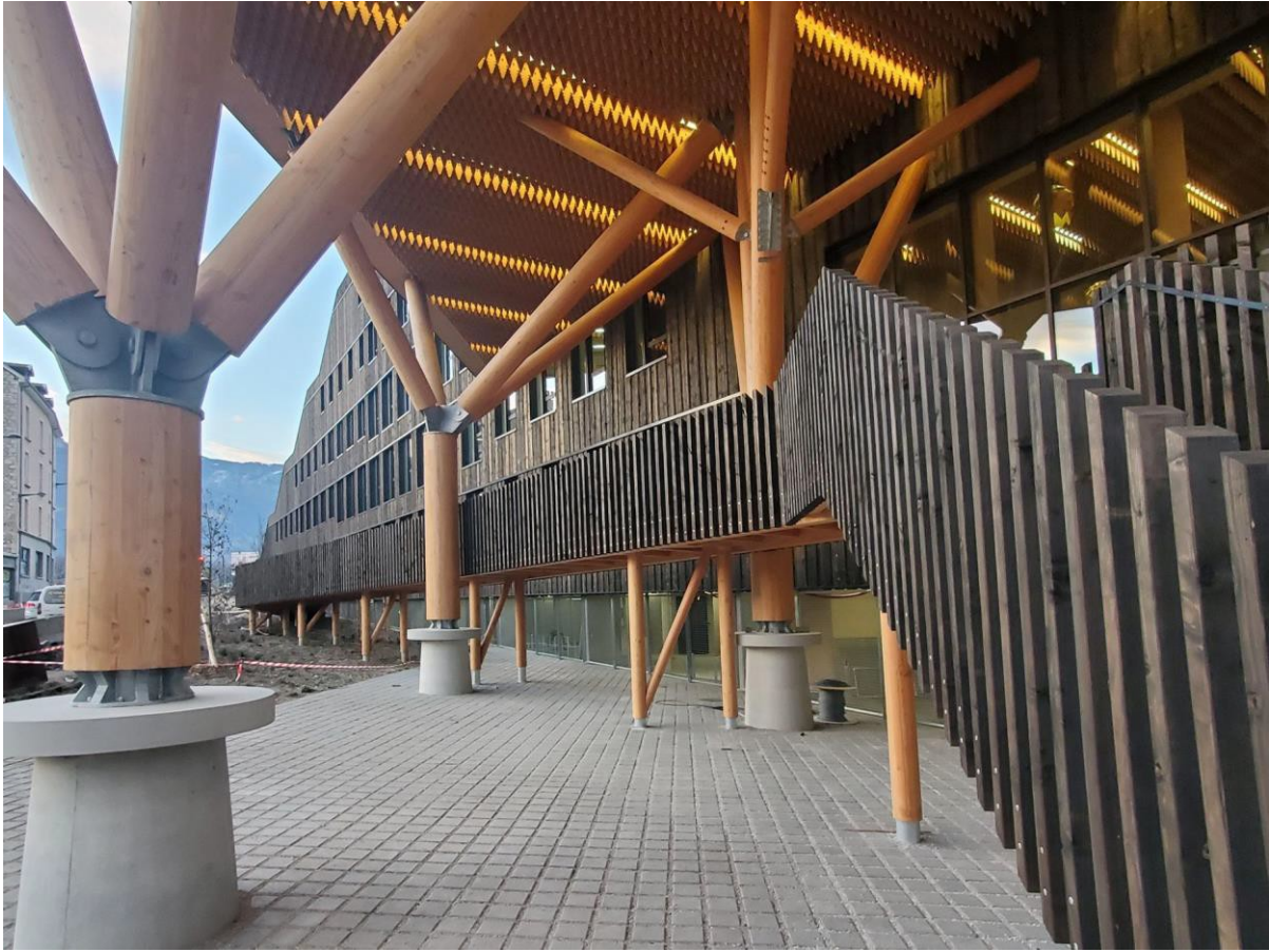
Image 3 : Photo de chantier
