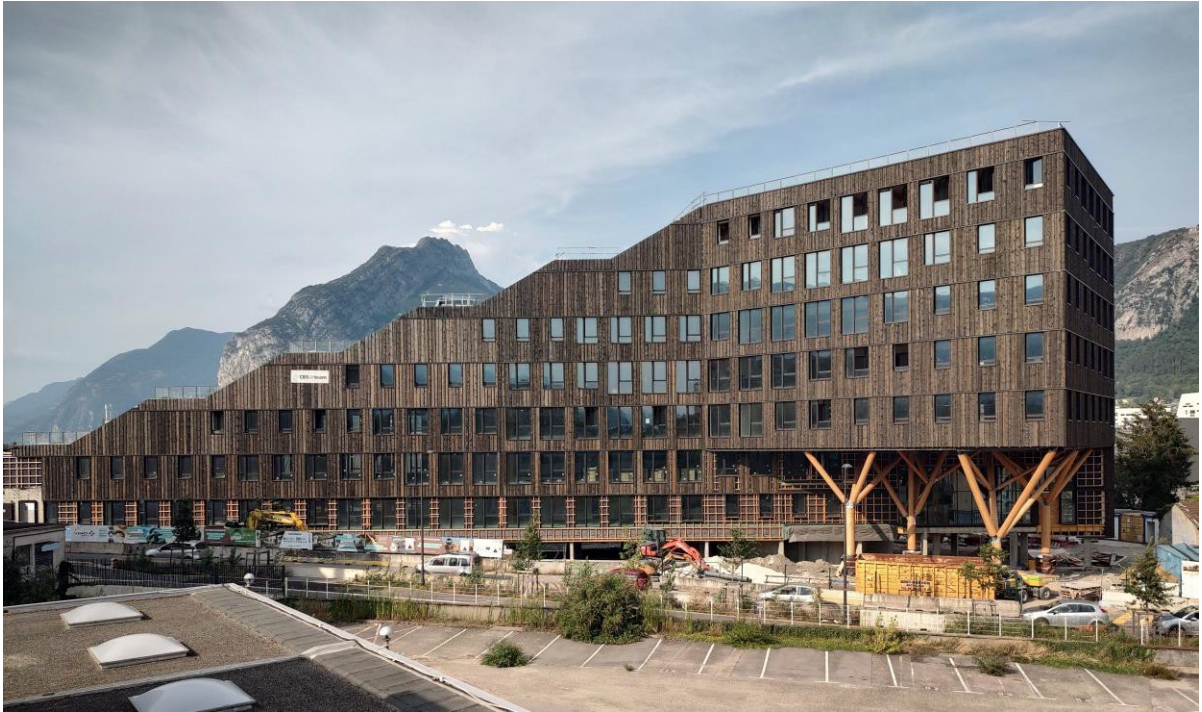
Image 1 : Photo de chantier
