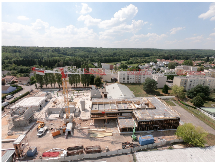
Chantier du Collège Elsa Triolet à Thaon-les-Vosges
