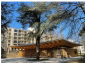
CBT propose deux types de renforcements. D'une part, pour le pavillon, il faut renforcer les porte-à-faux aux angles et pour cela, poser par dessus, au milieu de l'isolation, des sablières solides mais invisibles. Même souci de stabilité des angles de la halle, qui seront renforcés par le recours à l'acier. En fait, la modification est minime puisque le cadre périphérique pour la membrane et les poteaux sont en acier.
