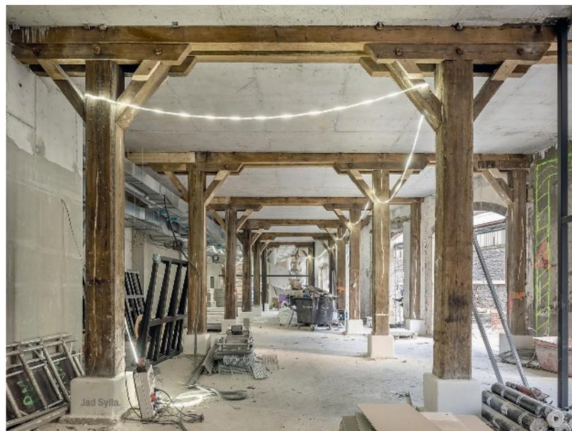
**Les préconisations ont été de trois types : aucun renforcement, renforcement de certaines pièces ou certains assemblages, remplacement par des pièces neuves de certaines pièces trop dégradées.** J. Sylla
