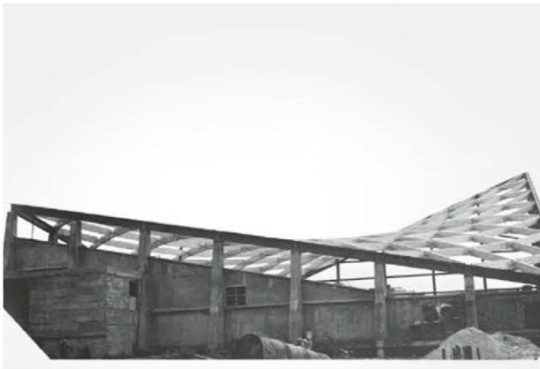
7 Piscine de Coursailles à Aulnay-sous-Bois, arch. Verdoia et Berthelot, ing. Lourdin, ent. Bermaho
