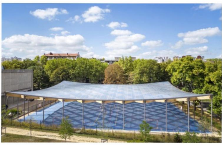
Il faut y regarder à deux fois pour réaliser que cette couverture n'est, par ailleurs, pas plane : elle ondule entre 7 m – hauteur requise par la pratique sportive – et 10 m, le maximum autorisé par le PLU. La toiture est ainsi plus haute au centre des terrains, se rabaisse ensuite avant de se relever aux quatre coins. Ce mouvement assez imperceptible a été dessiné pour permettre la collecte des eaux pluviales dont les descentes sont dissimulées dans 12 des poteaux porteurs.
