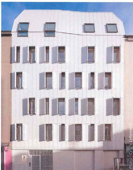
▲ Immeuble R+5 situé rue Dezobry à Saint-Denis (93), abritant dix logements sociaux. La structure est constituée à 80% de bois (CLT + L-C). Projet : JTB Architecture. Réalisation : BâtiPlaine pour Plaine Commune Habitat et 3F.
