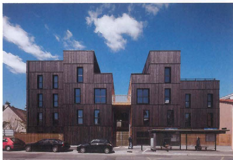
▲ Trente-cinq logements sociaux dans le quartier Branly-Boissière à Montreuil (93). L'opération est répartie dans deux ensembles en ossature bois préfabriquée, rue Étienne-Dolet (R+2) et rue Édouard-Branly (R+1 et R+2). Projet : LA Architectures (75) pour l'OPH de Montreuil.
