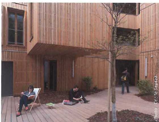
▲ Tête en l'air, une opération de trente logements sociaux (quinze réhabilités, quinze neufs) au cœur d'un îlot dans le 18 e arrondissement de Paris. La partie neuve du projet, à ossature bois, a été réalisée dans la cour intérieure de l'immeuble existant. Projet : Agence Koz (75). Maître d'ouvrage : Siemp (75)
