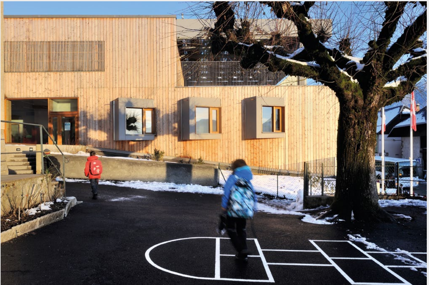
Le bardage est en mélèze provenant de la commune de Yenne , située à une trentaine de kilomètres de Saint-Jean-d'Arvey.
