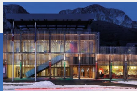
Vue de nuit de la façade principale.
